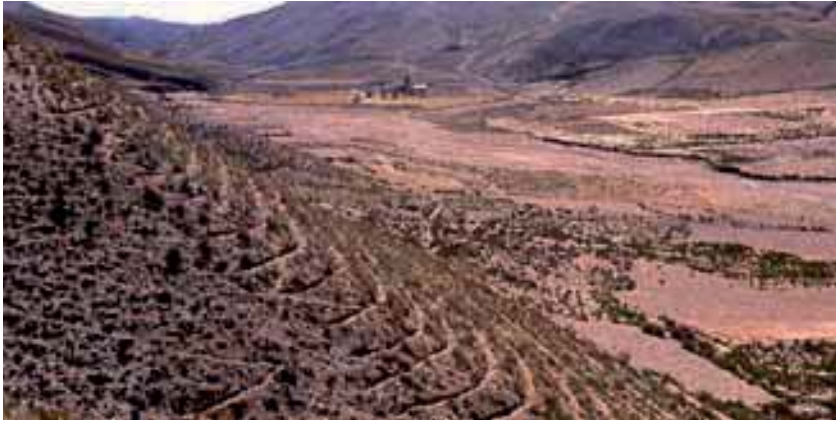
Zanjas infiltración Comunidad Huaraco Altiplano Central.
