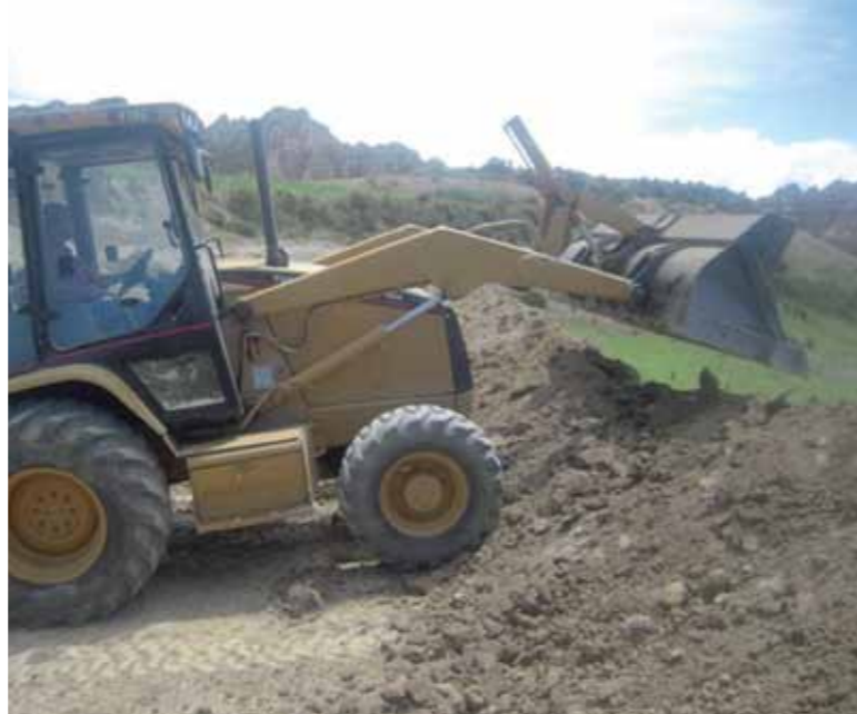
Gevraagd en ook gekregen: een echte graafmachine voor het zwaardere graafwerk.
